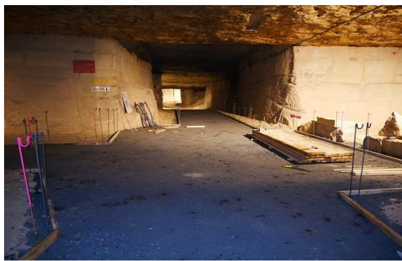
Piste en phase réalisation
