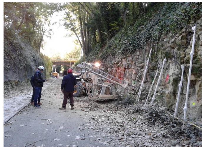
Phase forage pour scellement ancrage puis pose grillage
