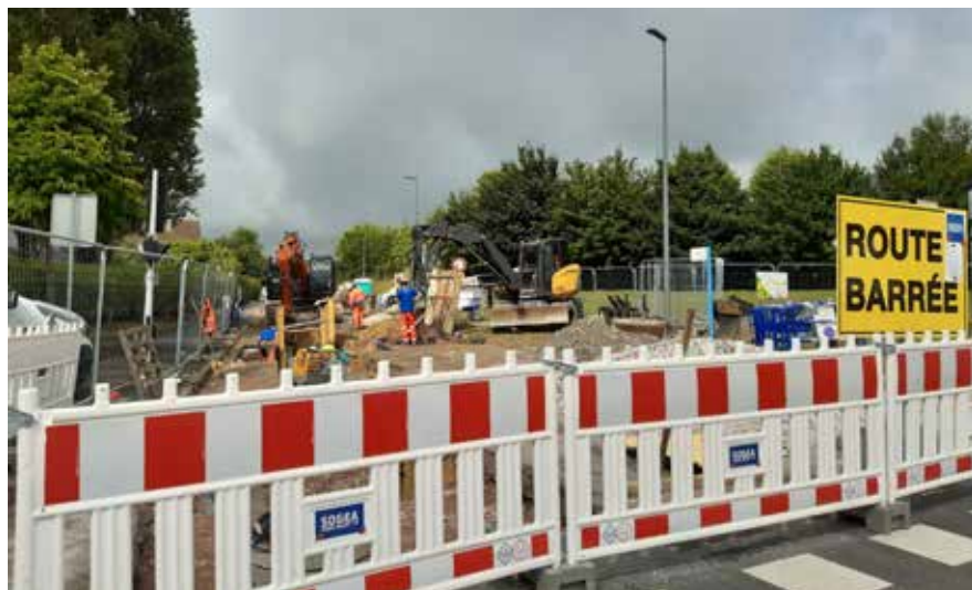
Barrée jusqu'en février 2022, la rue de la Folie sera ensuite mise en circulation alternée jusqu'à la fin des travaux.
