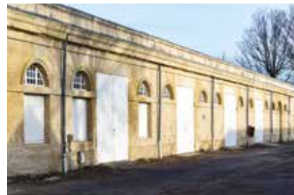
La rénovation des anciennes écuries débutera en 2020.
