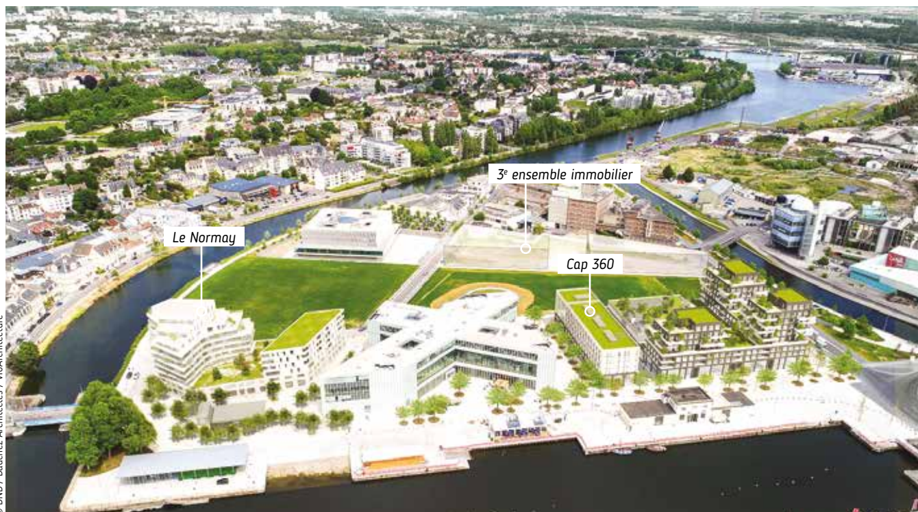
© DND / Dauchez Architectes / VibArchitecture
