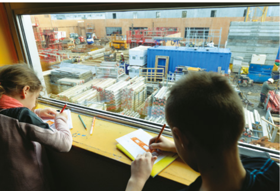
Chaque atelier est l'occasion de compléter le carnet de chantier avec de nouvelles photos des travaux.
