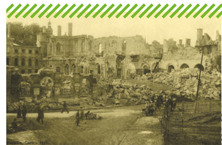
Les bombardements de l'été 1944 sont fatals à l'ancien Hôtel de Ville, ainsi qu'à la moitié des bâtiments entourant la place.
